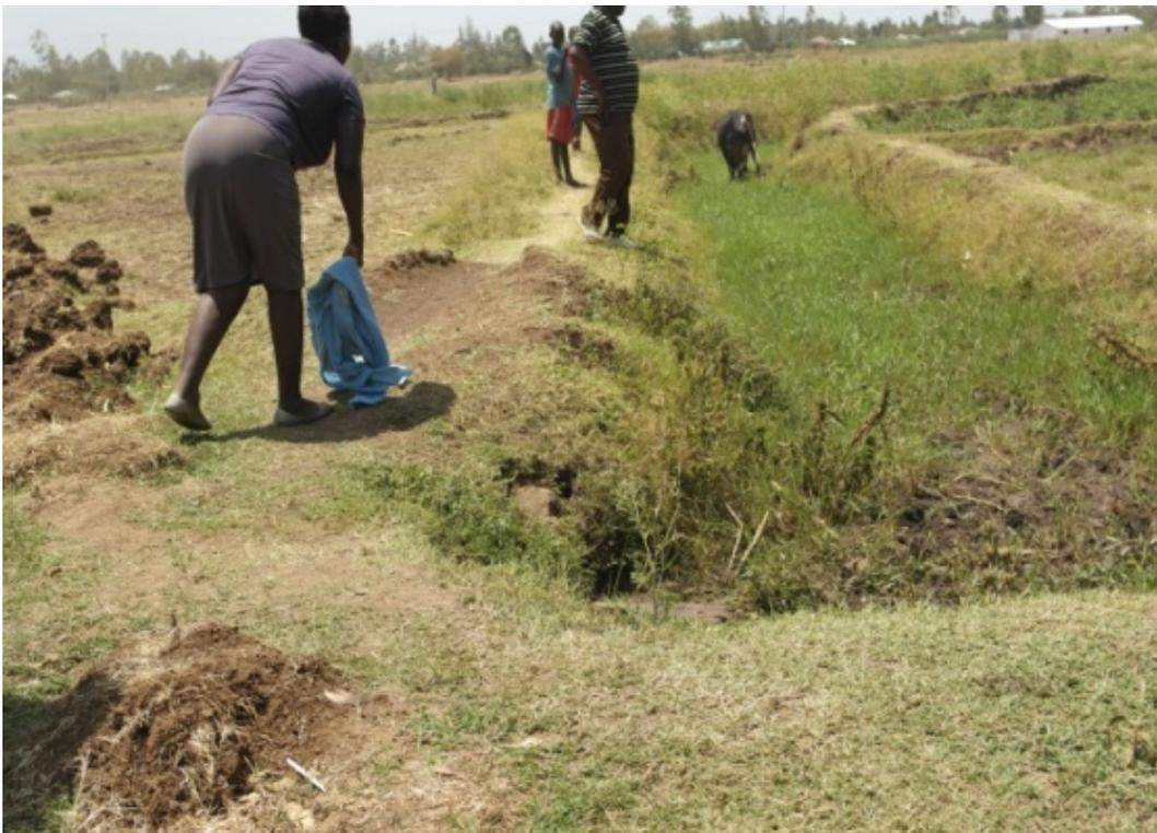
*Canales de Desagüe, para control de inundación, Nyando.*
